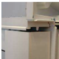
Postavljanje ALU vodilice
